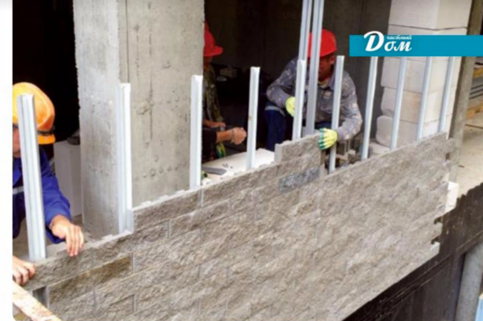
Облицовка блоками «зигзаг» стены здания с плиты перекрытия одновременно с кладкой стеновых блоков
